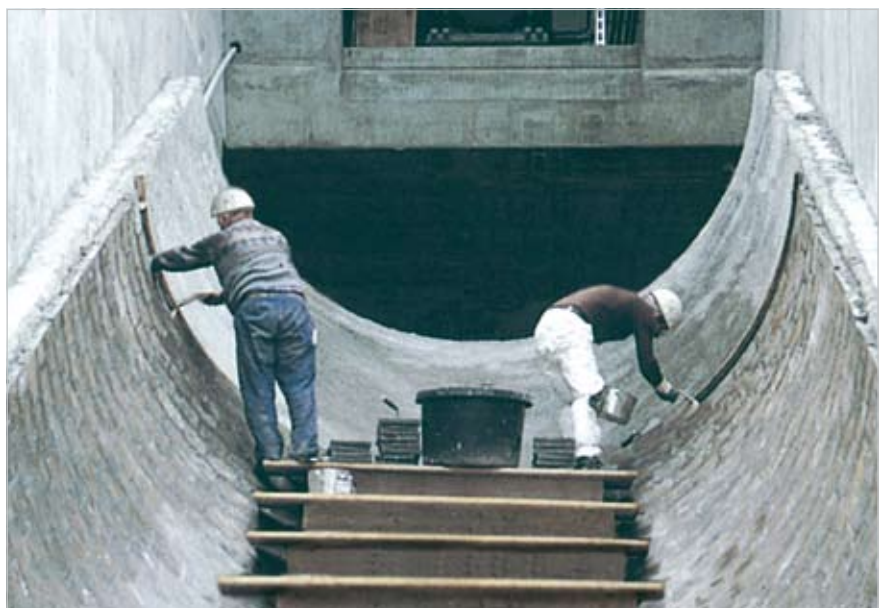
In Abwasserwerken werden häufig Schnecken-Hebewerke für die Förderung von Wasser eingesetzt. Zur Sicherung des Ringspaltes besteht die Forderung nach Verschleißfreiheit. Schmelzbasalt ABRESIST eignet sich auch bei Durchmessern von 3 000 mm und Längen von 15 000 mm.
