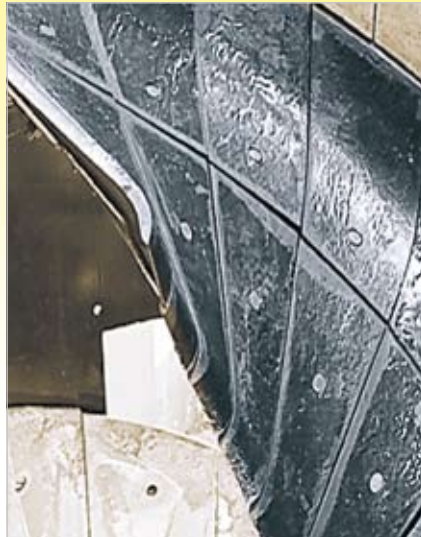
Schachtwendel im Steinkohlebergbau mit bewährter KALMETALL-C Auskleidung
