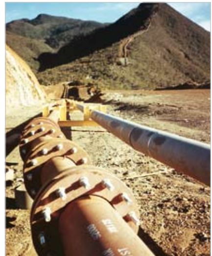
ABRESIST Rohrleitung zur hydraulischen Förderung von Erz
