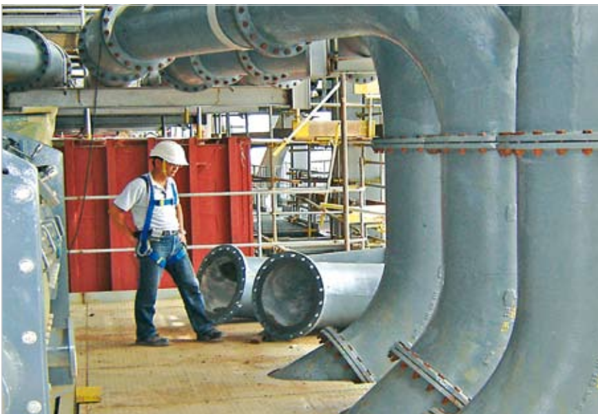
Typischer Einsatzfall für Hartguss KALMETALL-C sind Rohrsysteme; hier die Kohlestaubleitung eines Kraftwerkes in Südostasien
