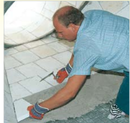
Sammeltrichter in der Sinterentstaubung mit KALCOR
