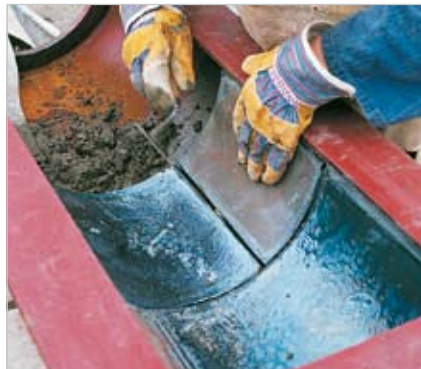
Verlegung in Zementmörtel
