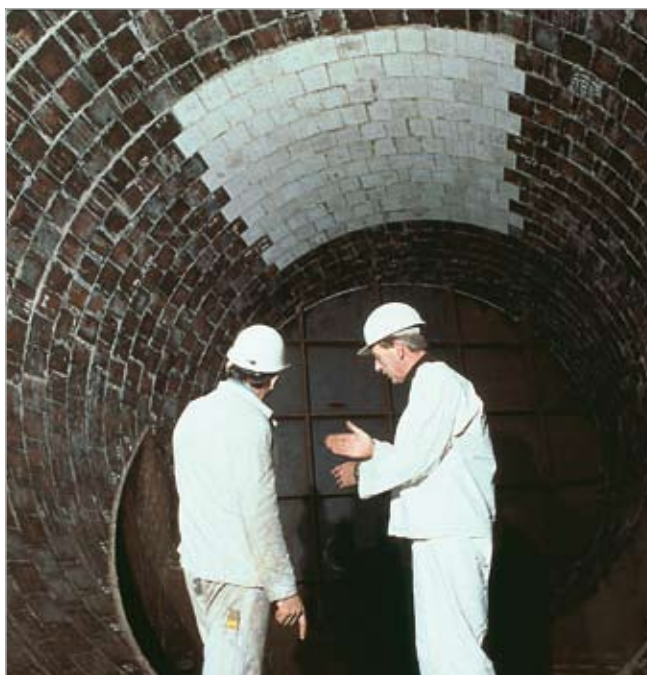
Im Hüttenwerk treffen abrasive Sinterpartikel mit 250 °C und hoher Geschwindigkeit auf die KALCOR Auskleidung, in der Kombination mit ABRESIST eine wirtschaftliche Lösung
