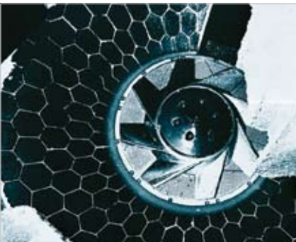
Wie in einem Riesensmischer werden in Pulpfern Altpapierballen zur Papier-Regeneration aufgemischt. Aufgrund erheblicher Verunreinigungen wird der Boden dauerhaft mit ABRESIST geschützt.
