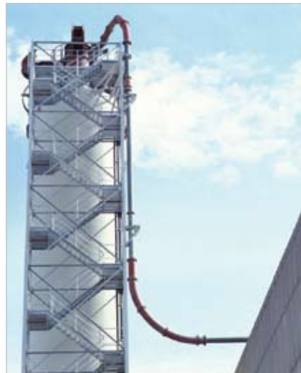
Die Zuführleitungen zu den Zementsilos sind in den Rohrbogen und geraden Nachlaufstücken mit ABRESIST gepanzert
