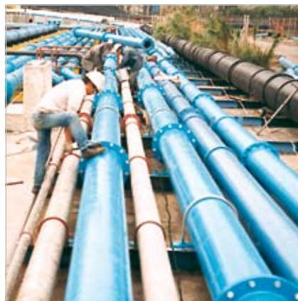
Montage einer Entschungs-Leitung in einem Kraftwerk in Fernost
