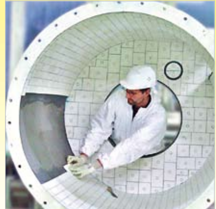
Auskleidung eines Zykloneinlaufes mit KALOCER; die Bogenwirkung ermöglicht die Befestigung radialer Formstücke in KALFIX Verlegemasse, die Stirnwand erfordert mechanische Befestigung mittels Anschweißhülse und Einlegestopfen
