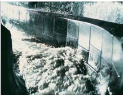
Rinnen und Trichter in jeder Form können mit ABRESIST verschleißfest ausgekleidet werden
