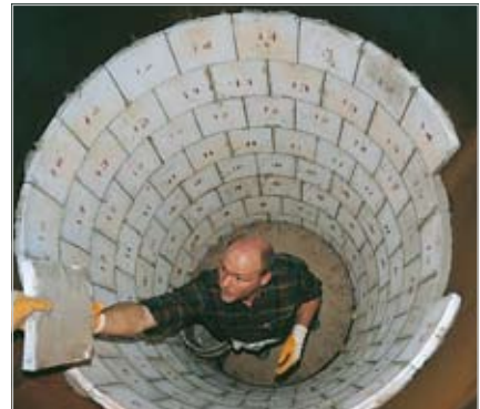
Wasserglaskitte bei Temperatur-Beanspruchungen
