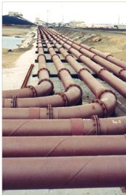
Weltweit erreichen ABRESIST Aschepföhrleitungen Standzeiten von über 30 Jahren. Dieses Kraftwerk in den Vereinigten Staaten verfügt über mehr als 10 000 Meter 294 mm ID-Rohre.
