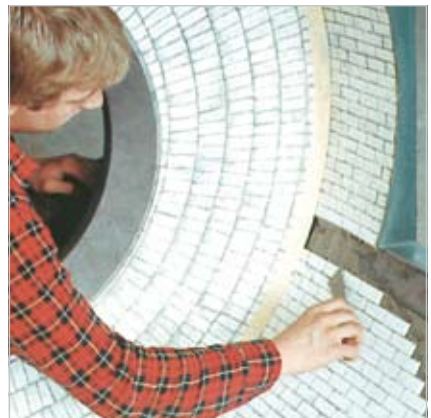
Flexible Nutzung ermöglichen KALOCER Mosaik mit 1,5 bis 12 mm; die Befestigung erfolgt mit KALFIX Epoxy-Verlegemasse
