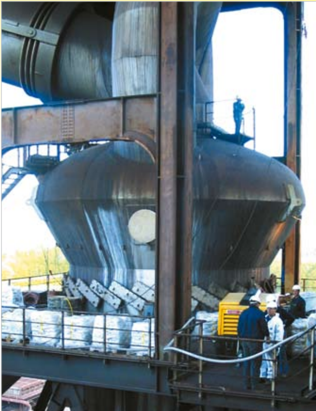
Wirblerauskleidung eines Stahlwerkes mit dem spritzbaren Hartstoffkompond KALCRET-BTS
