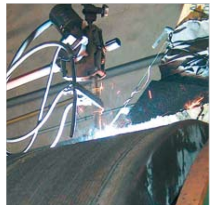
Schweißtechnische Regeneration einer Mahlrolle
