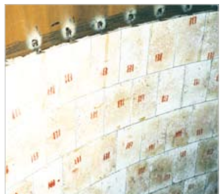
Hochtemperatur-Verschleißschutz: Entstaubungszyklon in einem Hochofenwerk in Europa
