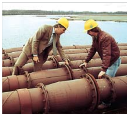
Dehnungsstück in einer hydraulischen Ascheleitung
