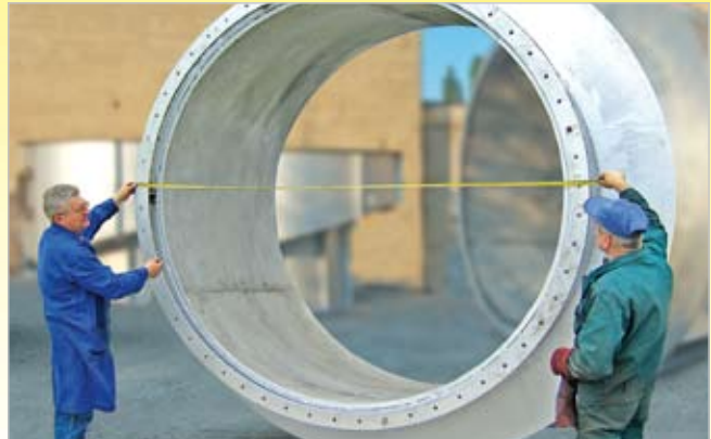
Auskleidung des Sichters in der Zementmahlung mit KALCRET-BNX, bis zu 3 200 mm Durchmesser
