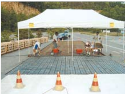
Schmelzbasalt hat sich weltweit auf Automobil-Teststrecken bewährt; hier die Verlegung von sogenannten Skid Tiles in der Schweiz
