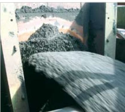
KERAFLEX Auskleidung im Bunker eines Umschlagbetriebes
