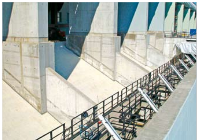
Schutz einer Koksrampe für sicheren Dauerbetrieb mit KALCERAM-K auf der Gleitfläche, KALSICA-N im Bereich hohen Verschleißes und hoher Temperaturbelastung sowie KALMETALL-C im Bereich der Schlagbelastung
