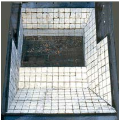
Bunkerauskleidung mit KERAFLEX-KRM Elementen in einem Stahlwerk
