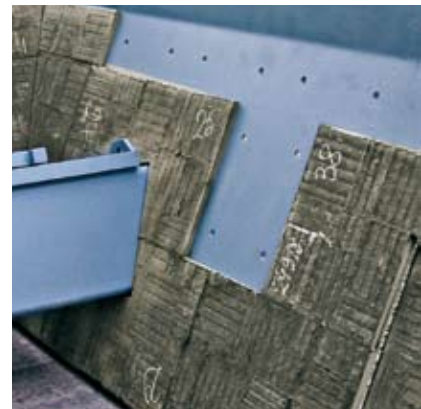
Mechanische Befestigung der KERAFLEX-WRM Elemente für leichte Austauschbarkeit; große Elemente sind mit 4 Befestigungspunkten versehen
