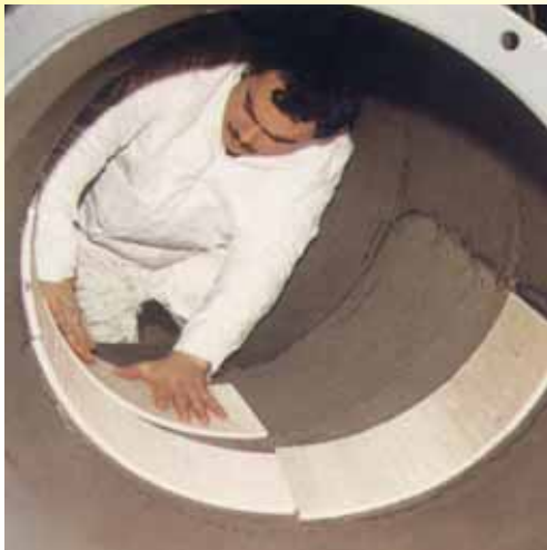
Auskleidung einer Entstaubungsleitung für Klinker mit 6 mm dicken KALOCER Mosaiken in KALFIX Epoxy-Verlegemasse
