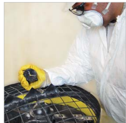
4. Mischen für 4 bis 5 Minuten, Ergebnis prüfen
