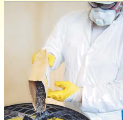
2. Faserkomponenten falls erforderlich hinzufügen und mind. 1 Minute mischen
