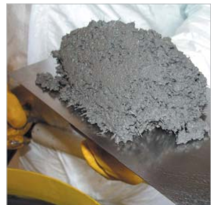
6. Die steif / plastische KALCRET Spachtelmasse (X) wird mit einer einfachen Maurerkelle aufgetragen
