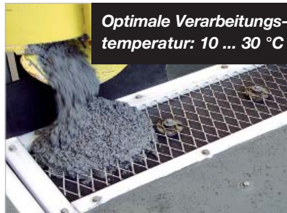
2. Gießmasse nach Vorschrift vorbereiten
