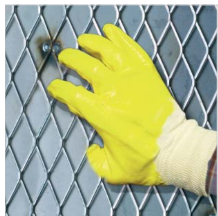
Steife und starre Befestigung, Abstand zur Wand ca. 5 mm
