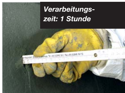
4. Schichthöhe prüfen und ggf. gleichmäßigen
