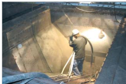
Auskleidung einer Windbox unterhalb des Sinterbandes im Stahlwerk
