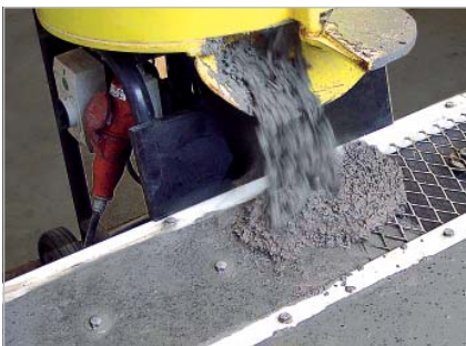
3. Schalung sorgfältig füllen
