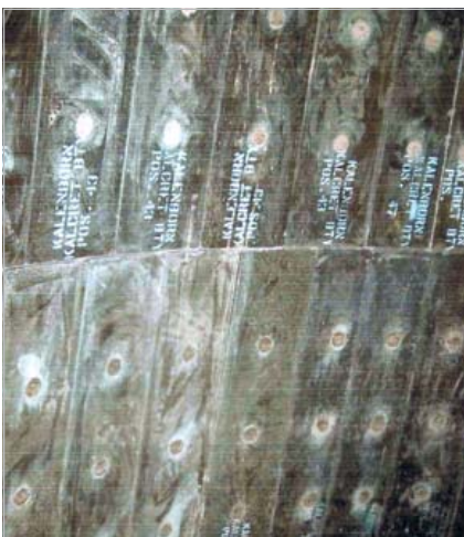
Vorgefertigte Formstücke z. B. für Zyklonauskleidung
