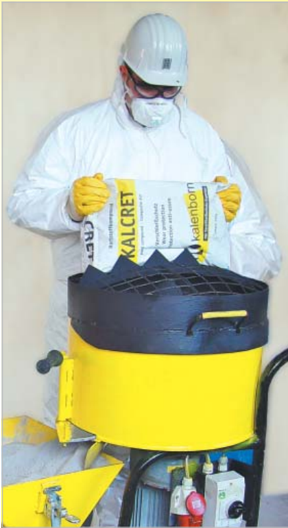
Materialaufgabe in die Kalenborner Spritzanlage
