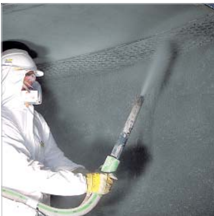
Überkopf-Verarbeitung ist problemlos möglich
