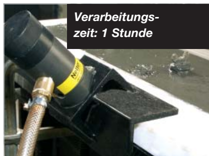
4. Außenvibrator zur Verdichtung einsetzen
