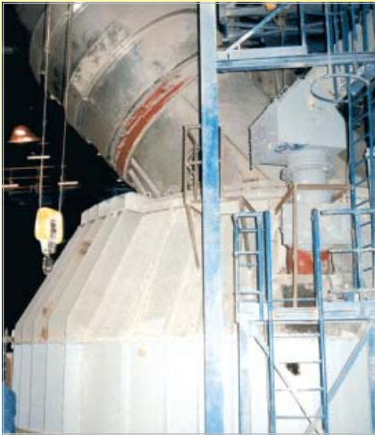
Auskleidung einer Rohmehlmühle im Zementwerk
