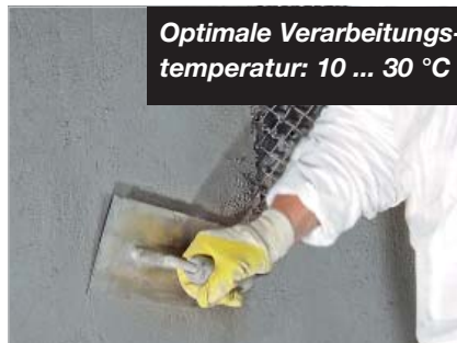
2. Nach dem Auftragen einfaches Glätten
