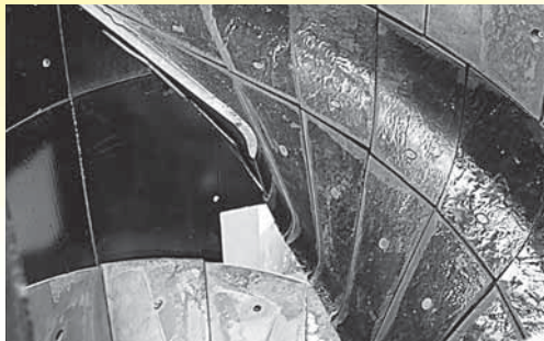
Schachtwendel im Steinkohlebergbau mit bewährter KALMETALL-C Auskleidung
