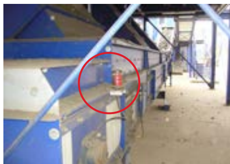
Stehlagerschmierung einer Förderbandanlage
