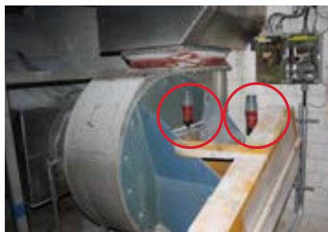
Stehlagerschmierung an einer Lüfteranlage
