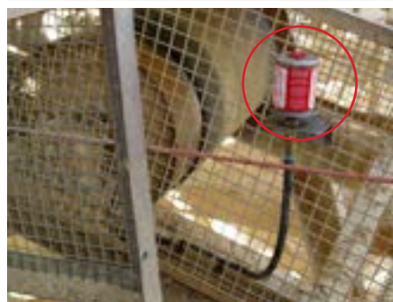
Stehlagerschmierung einer Förderbandanlage
