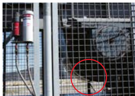
Stehlagerschmierung einer Förderbandanlage
